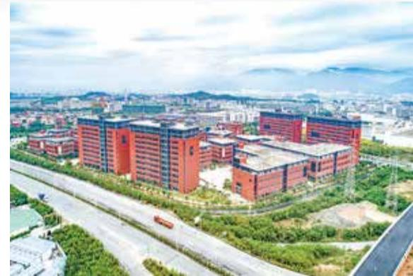
2015年，厦门公司承建完成的厦门生物医药园，工程整体73%的预制率和89%的装配率位居同期全国之首。其发明专利、装配式建筑施工经验，广泛用于后续中标的房建、管廊、地铁等项目施工，大大提升工程建设效率。
