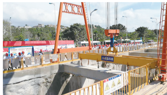
观摩现场管节拼装作业
