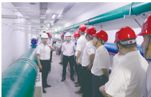
地下综合管廊工程实体介绍
