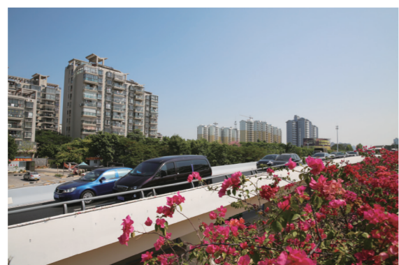
进行工程改造后的仙岳路焕发新风貌。
