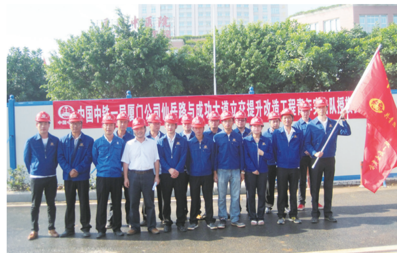
中铁一局厦门公司仙岳路提升改造工程青年突击队风采。
