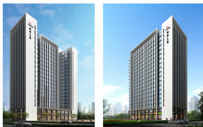
中铁海新大厦
