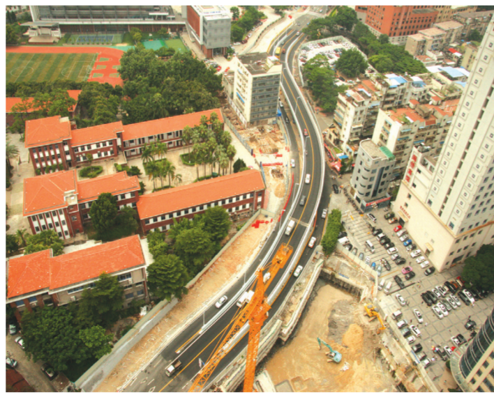
由中铁一局集团厦门建设工程有限公司改造后的文园桥全景
