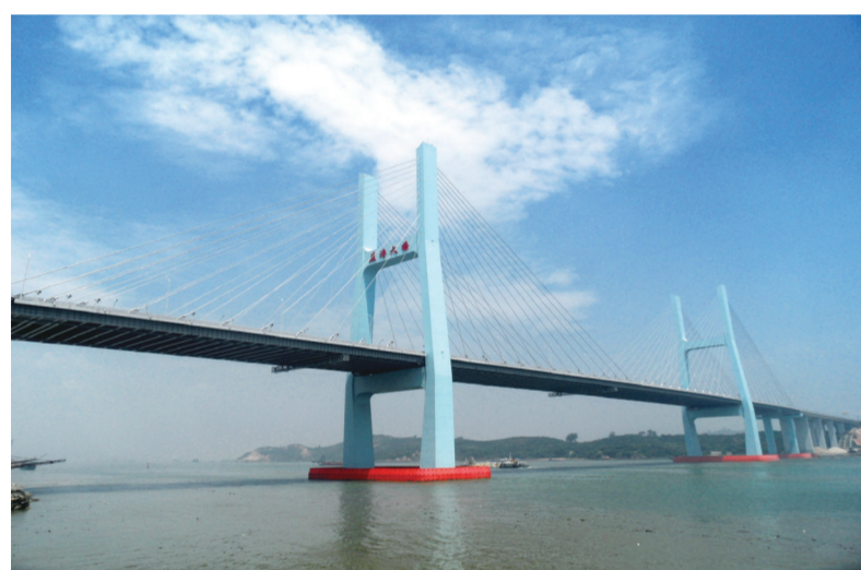
由中交一公局厦门工程有限公司承建的厦漳大桥南汉主桥全景
