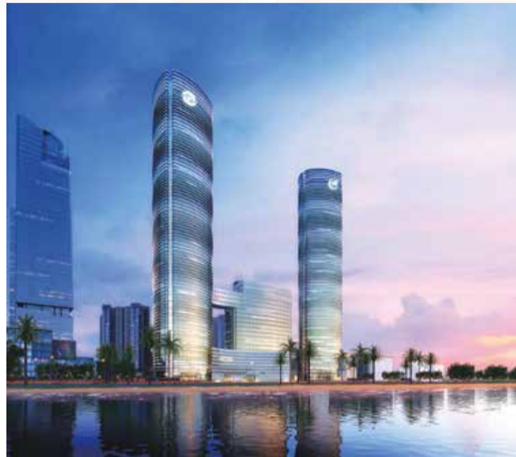
图为中建三局厦门分公司承建的中航紫金广场
