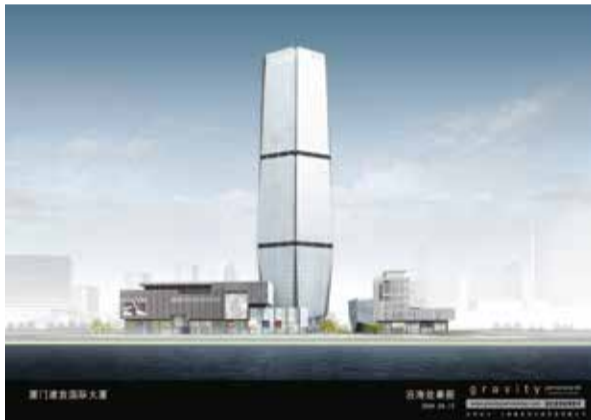
图为中建三局厦门分公司承建的建发国际大厦
