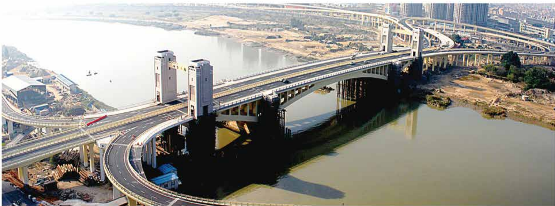
图为由中交一公局厦门公司承建、被誉为泉州最美大桥的“田安大桥”，2012年获福建省市政类最高信用评价等级A级
