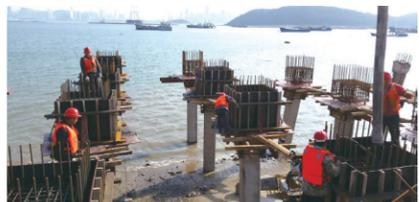
4月21日，在休闲广场三区现浇面板混凝土浇筑前检查验收时，一根绑得有点倾斜的钢筋引起了项目部工程部长王海南的注意，经仔细查看发现，原来这根钢筋超出设计1厘米，工人图省事，没有进行切割便直接进行绑扎。王海南连夜安排8名工人，耗费6个小时，完成钢筋拆除，并重新按要求绑扎到位。
