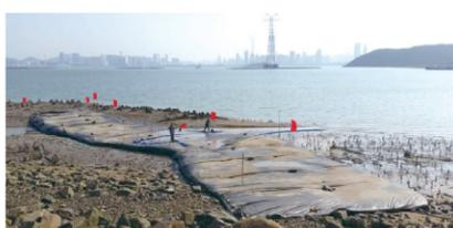
在项目策划阶段，就有采用搅稀泵送吹填的施工工艺的声音，施工不受潮水影响，功效快，成本低。项目部考虑淤泥搅稀后，红树林生长需要的肥沃土壤中的有机物质被离析，对红树林的成活产生重大的影响，且搅稀淤泥对海洋的环境污染严重，最终我们选择了环境保护和工程质量。项目施工负责人王炎山说：“工期紧，可以采取补救措施，合理组织施工，不管白天黑夜、不管刮风下雨，只要施工条件允许，只要潮水满足施工作业要求，泥驳就进行抛泥作业施工”。
